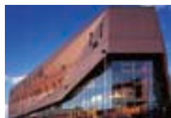
Высшая школа искусств, Клермонт-Ферранд, F Architecture Studio, Париж Raimond SA, Юлиен де Конделлос TECU® Классика
