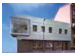
Японский ресторан, Милан, I Studio di Architettura Clerici, Gallizia Tutucci, Милан Copermont S.r.l., Глузон (Болгария) TECU® Олово
