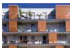
Жилое сооружение „Le Galilée“, Rennes, F Chouzenoux et Associés, Rennes SABM, Guichen TECU® Сетка Классика
