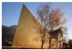
Церковь Сан Джоккомо, Ливес, I Höller & Klotzner Architetti, Мерано MetallRitten S.r.l., Коллальбо TECU® Латунь
